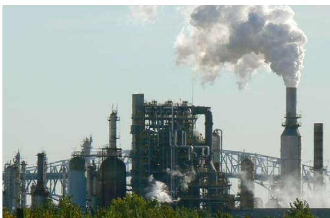
图表 9.2-3 对流化催化裂化装置的催化剂再生器进行排放控制的BELCO EDV湿式洗涤器 32
